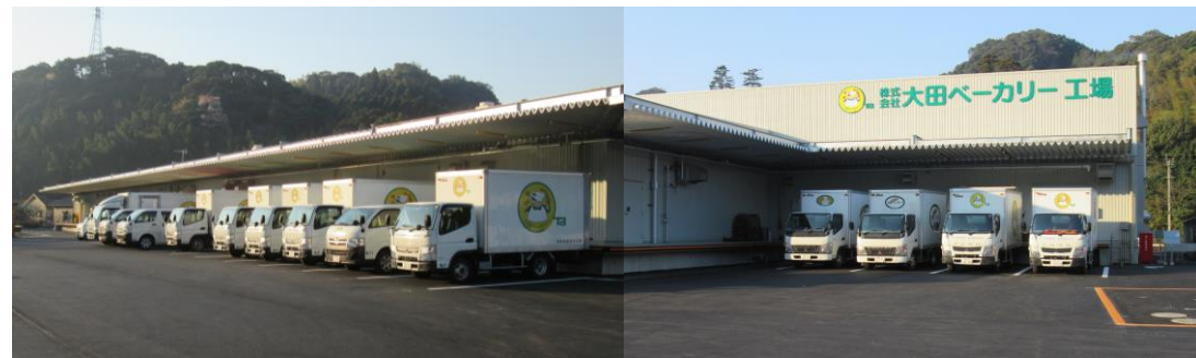
新工場 平成26年1月竣工
